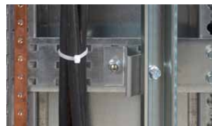
Les supports réf. 0 201 95/96 permettent la réalisation d'un bornier à plat ou incliné. De plus ils peuvent être utilisés pour fixer les câbles et pour fixer jusqu'à deux barreaux de terre
