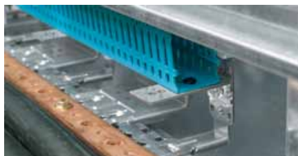
Les goulottes se fixent sur les supports à l'aide des rivets isolants livrés
