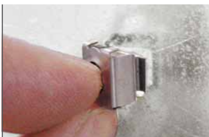
Mise en place des écrous-cage, par l'arrière de la platine métallique.
